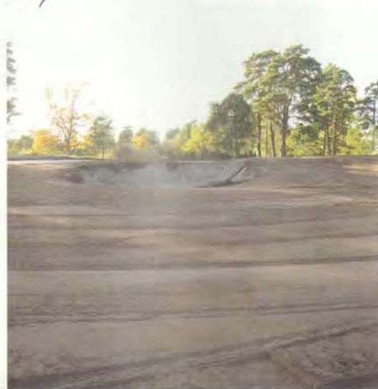
Utläggning av växtbädd, 15 centimeter lagertjocklek utanför greenytan, cirka 3.500 kvadratmeter.
