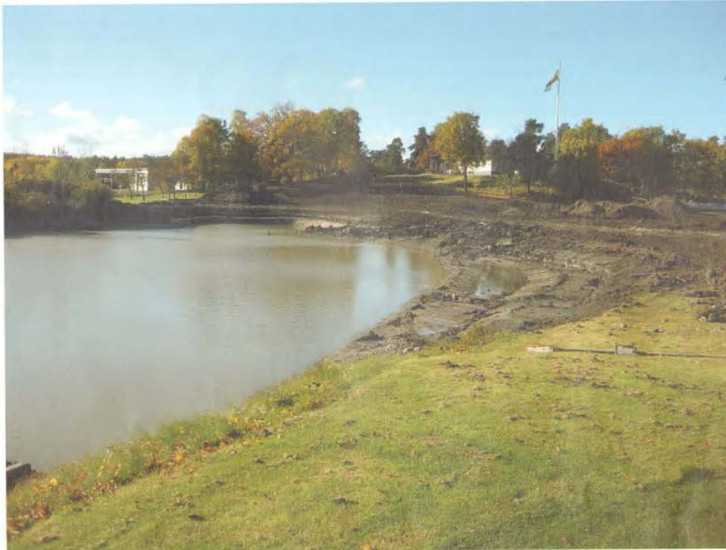
Grovschaktutvidgning av damm med 300 kvadratmeter. Massorna används till greenkomplexet och till att höja fairway ett par decimeter för att säkerställa god ytavrinning.
