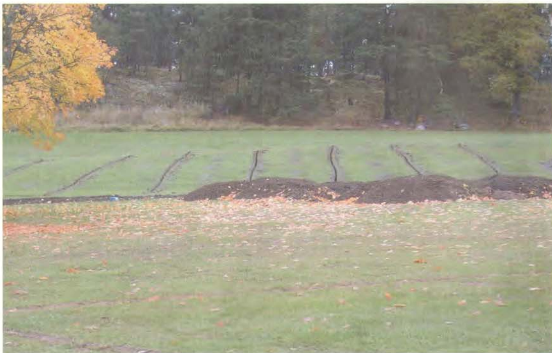
Täckdikning av fairway med c-c fem meter, cirka 2.000 löpmetrar.
